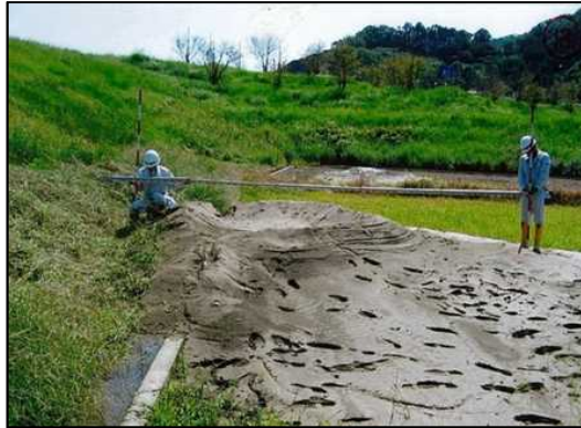
洪水時の堤防等の漏水
