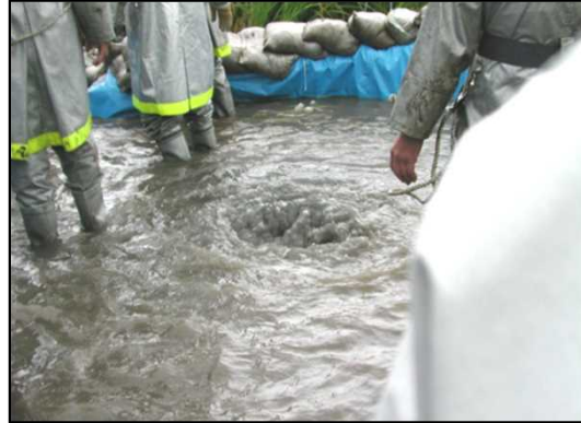
洪水時の堤防等の漏水
