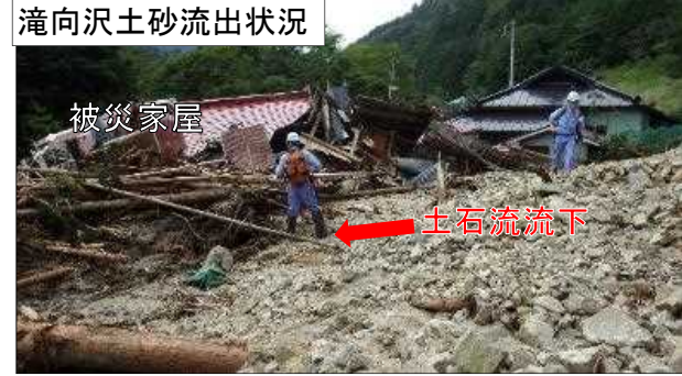
土石流等 栃木県日光市芹沢 にっこうし せりさわ
