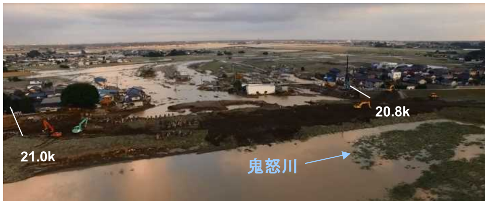
応急復旧状況(9/12)
