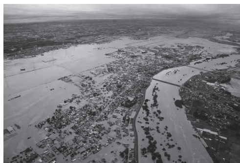
平成27年9月関東・東北豪雨 (常総市上空より撮影)
