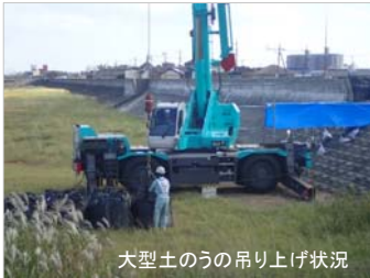
大型土のうの設置状況
