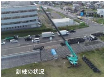
大型土のうの吊り上げ状況
