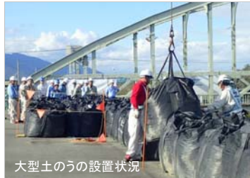
大型土のうの吊り上げ状況
