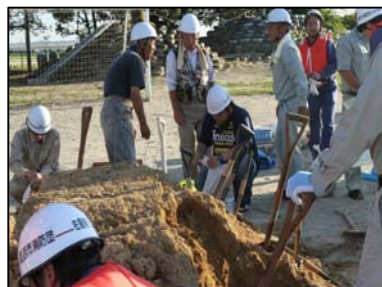
水防工法 月の輪工(土のう作成)
