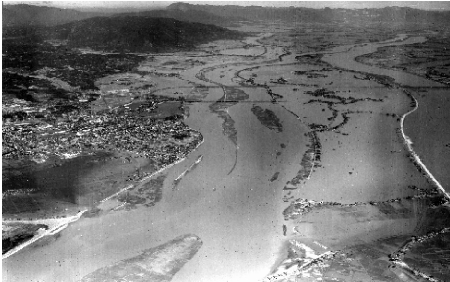
木曾三川下流部の浸水状況
