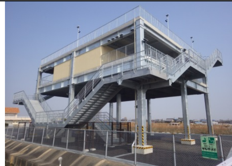
北部地区津波避難タワー(H30.2.28 完成)
