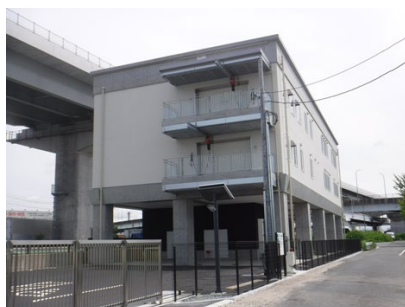
【飛島村】 新規避難所の建設
