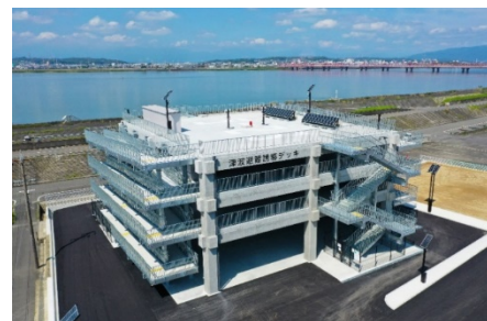
【桑名市】 津波避難誘導デッキの建設
