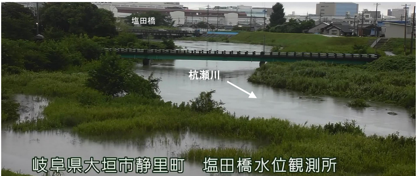
杭瀬川の出水状況（8月14日17時頃）8.8k付近
