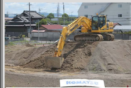
無人化施工重機による堤防復旧
