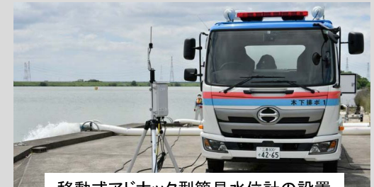
移動式アドホック型簡易水位計の設置と排水ポンプ車による排水作業
