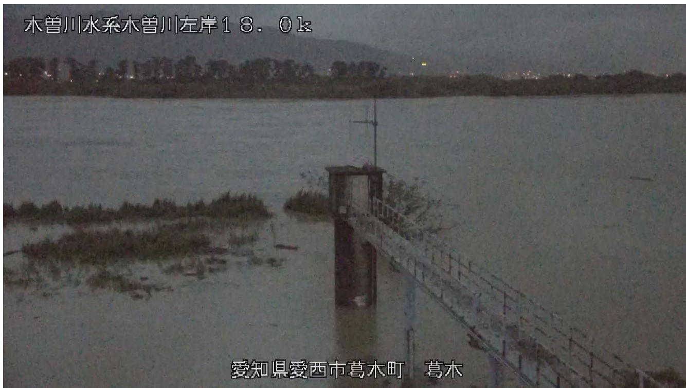
木曾川の出水状況（8月14日19時頃）18.0k付近
