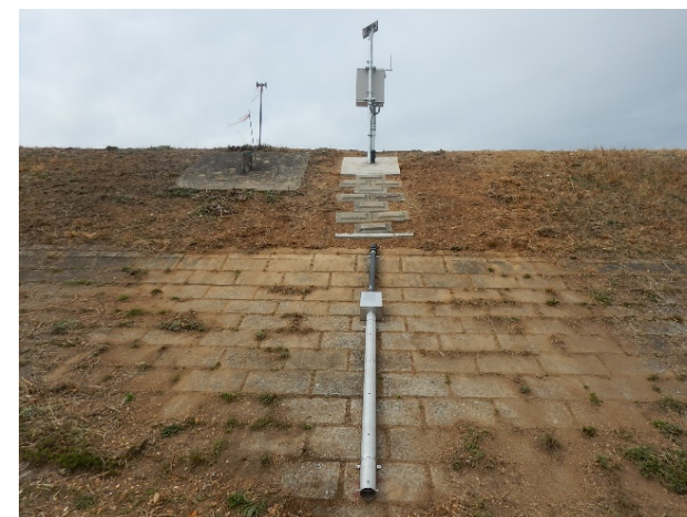
危機管理型水位計設置状況写真 (揖斐川右岸13.4k)
