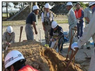
水防工法 月の輪工(土のう作成)
