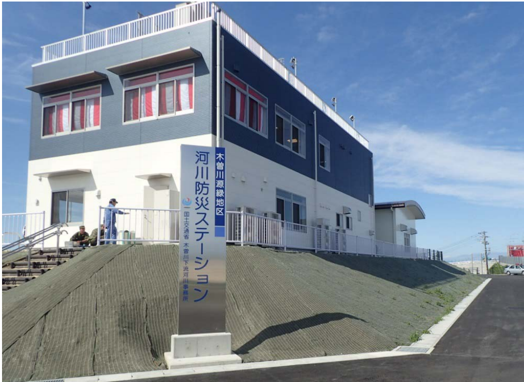
木曾岬町防災センター (H30.5.20 完成式)
