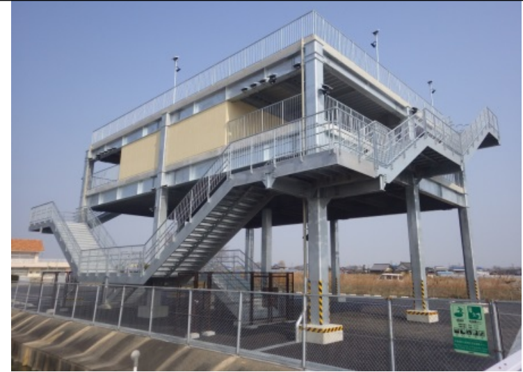
北部地区津波避難タワー(H30.2.28 完成)
