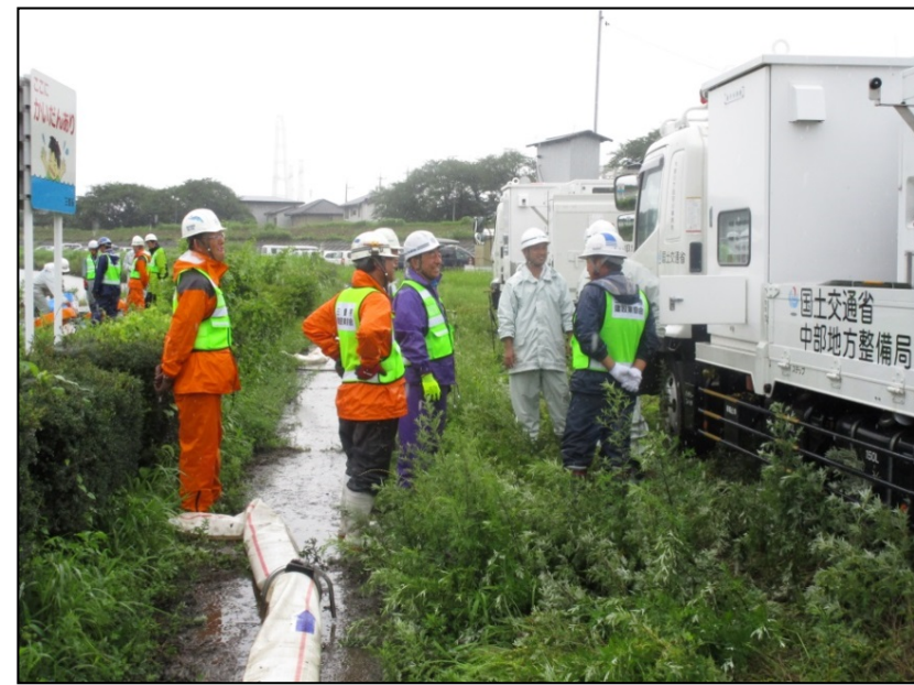
排水ポンプ車操作説明状況
