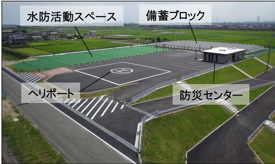
城南河川防災ステーション(H26年完成)
