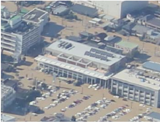
常総市役所の浸水の状況
