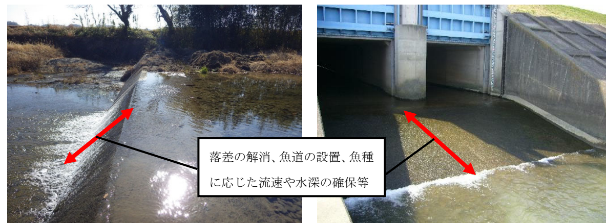
写真 5-1 樋門・樋管等の横断工作物の改善における連続性再生イメージ
