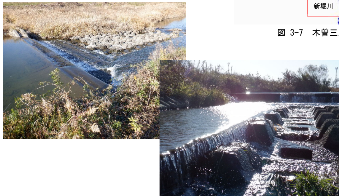
写真 3-1 肱江川における落差工の状況
