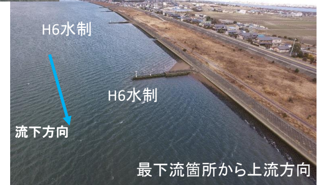
H28_揖斐川左岸 大島地区
