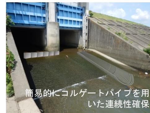
簡易的にコルゲートパイプを用いた連続性確保
