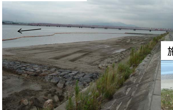
施工直後(H20)
