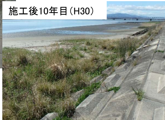
再生干潟における土砂の堆積状況(源緑輪中地区)
