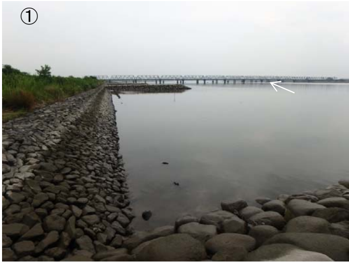
養浜未実施区間
