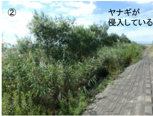
再生箇所の下流端
