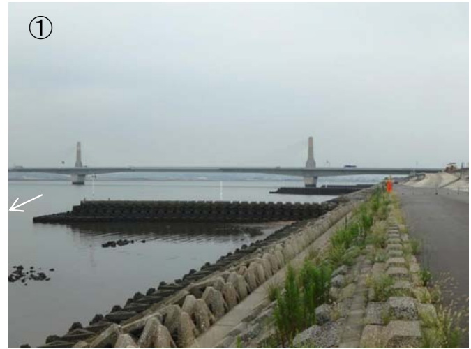
養浜未実施区間
