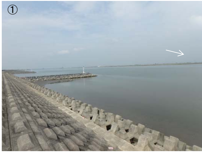
水制工の根部付近に干潟が干出
