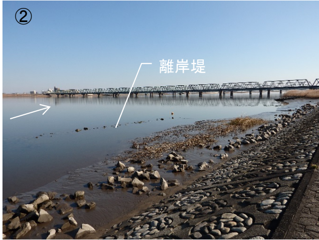
再生箇所の干潮時の様子 (平成29年12月)
