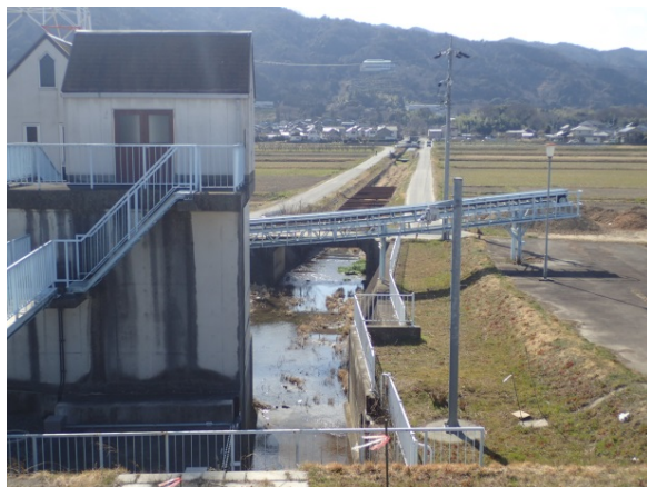
揖斐川支川岡谷第一ひ管上流水路
