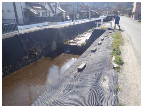
落差があり連続性が確保されていない
