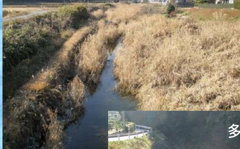
肱江川中上流部
