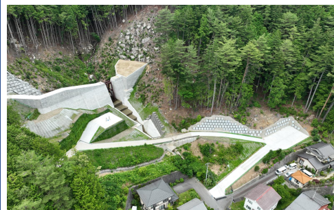
たしろさわ 田代沢砂防堰堤の整備状況 (長野県木曽郡上松町)
