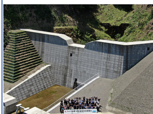
ガラン谷第1砂防堰堤の完成 (岐阜県本巣市)
