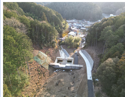
しんめいぼらたに 神明洞谷砂防堰堤の完成状況 (岐阜県美濃市)
