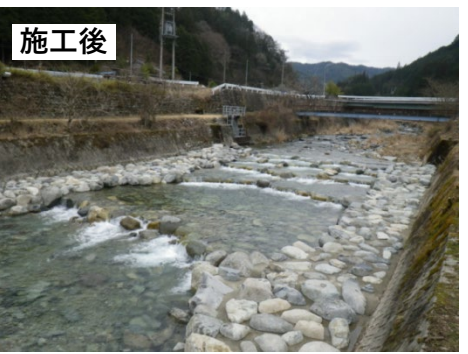
竹原川における魚道の改築（石組工法）（下呂市）
