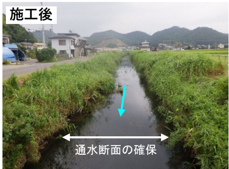
石田川における河道掘削（岐阜市）
