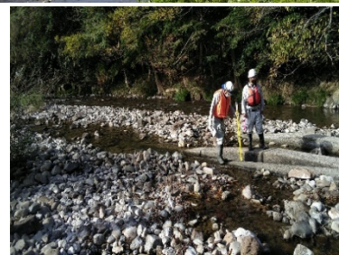
魚道点検の様子 （R3.11.4 津保川（関市）にて）
