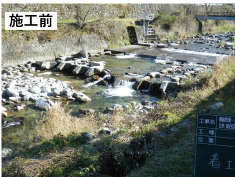
竹原川における魚道の改築（石組工法）（下呂市）
