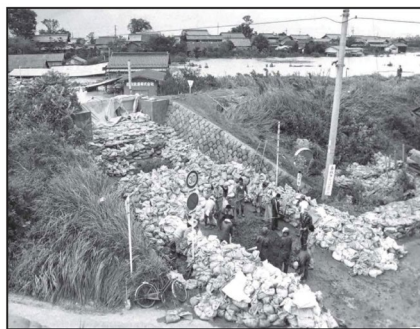
旧輪中堤で浸水をくい止めた水防活動(S51.9.14付 岐阜新聞)
