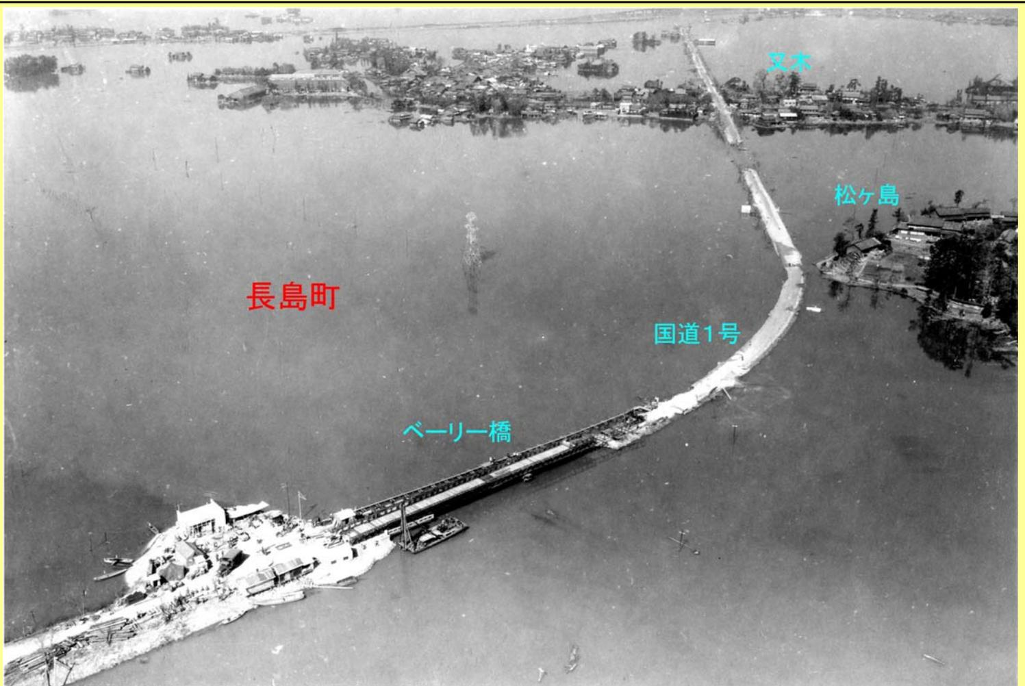
写真名称： 長島町の国道1号に設置されたベアリー橋を上空南西方向から望む
