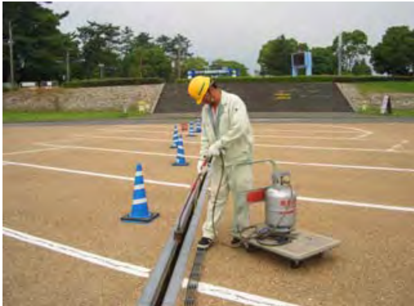
大型バーナーによる焼却作業状況
