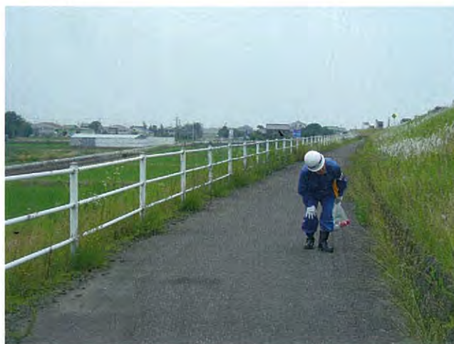
場所：海津市海津町古中島地先 （長良川右岸17.0k付近） 調査箇所：川裏堤防のブロック積の隙間
