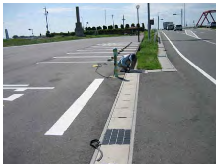
④防災ステーション付近の排水側溝
