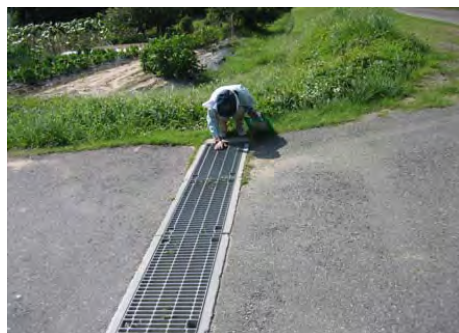
③堤防の坂路部分の排水側溝
