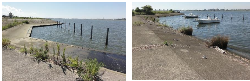
写真3 変形護岸の施設状況
