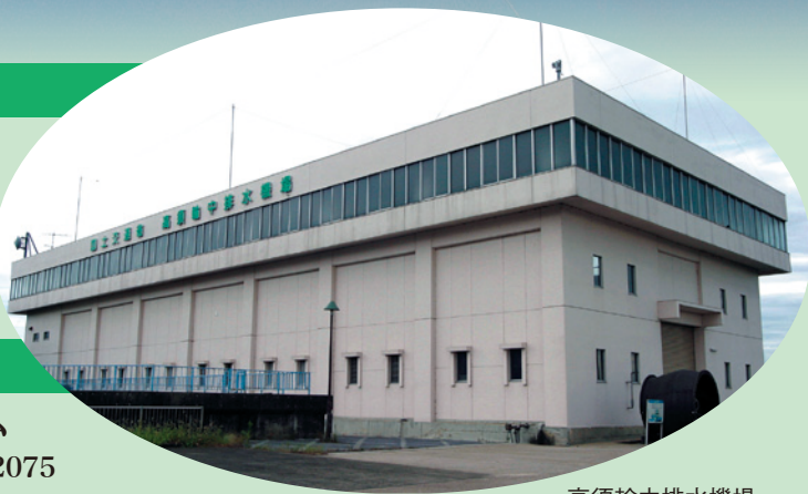
高須輪中排水機場
