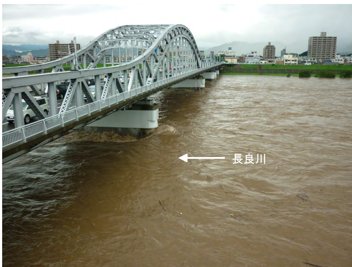
長良川の出水状況（8月17日17時頃）忠節橋付近（岐阜県岐阜市）
