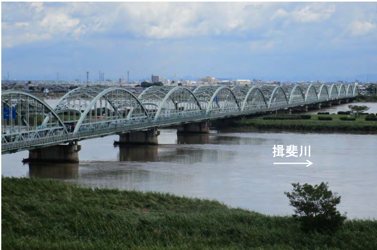
揖斐川の出水状況（8月11日10時頃）伊勢大橋付近
