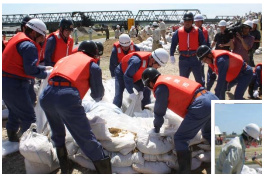
消防団による水防工法の実施(釜段工)
