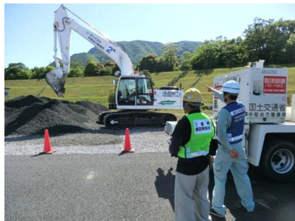
無人化バックホウによる土砂撤去
