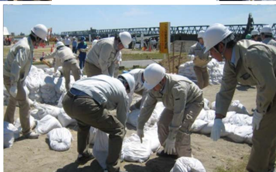
大学生による水防工法の実施(月の輪工)
