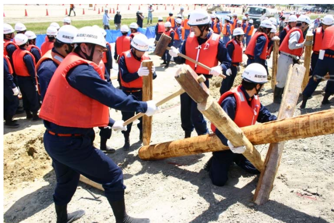
メイン会場 水防工法(杭打ち積み土のう工)
