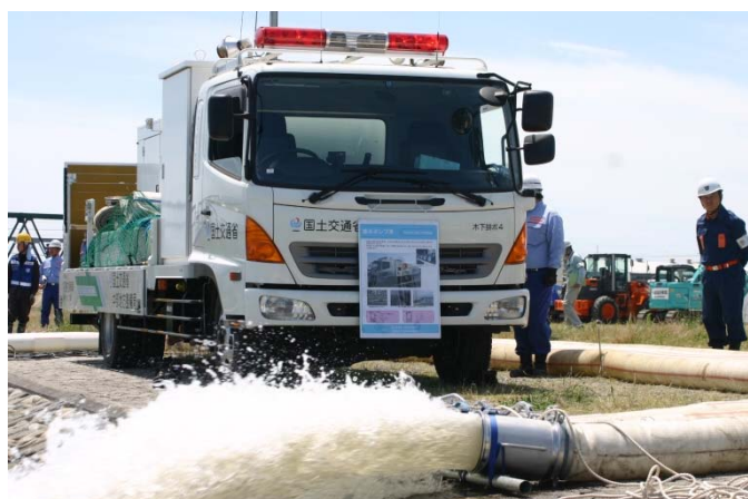
メイン会場 排水ポンプ車による排水作業
