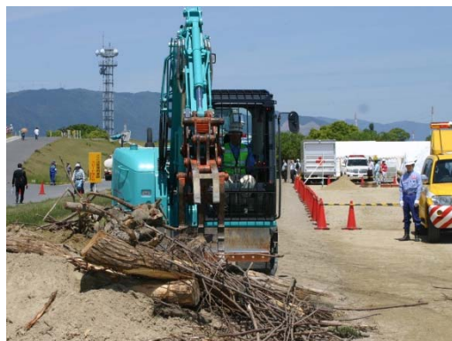
道路啓開(流木の撤去)
