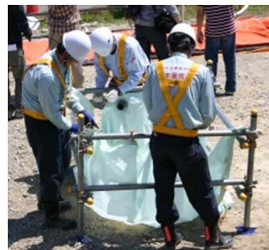
新技術を用いた水防工法 (土研式釜段工)
