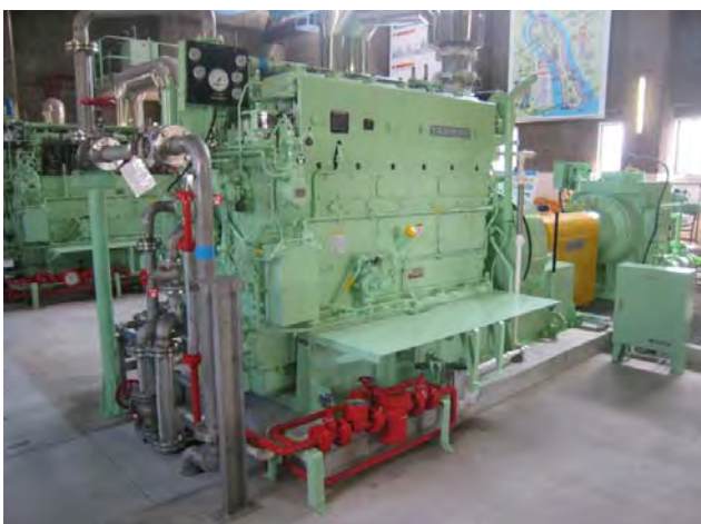
【復旧が完了した1号主原動機】
