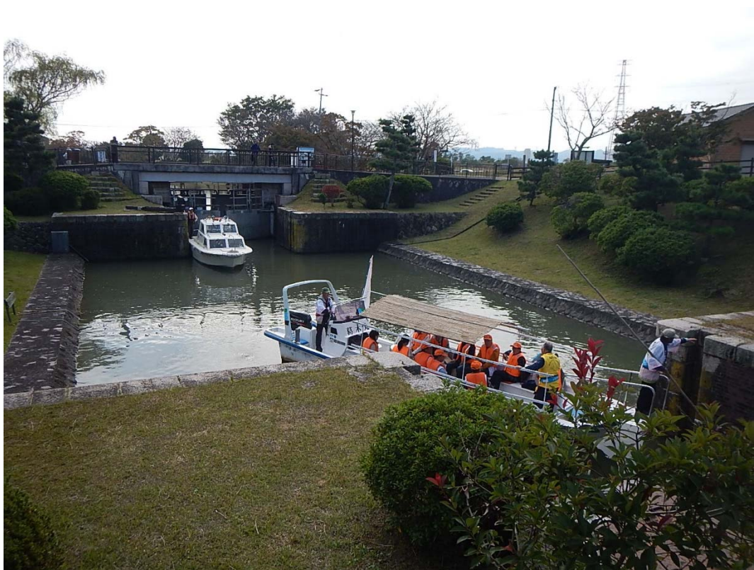
(船頭平閘門閘室 手前 葛木丸：奥 すいごう)
