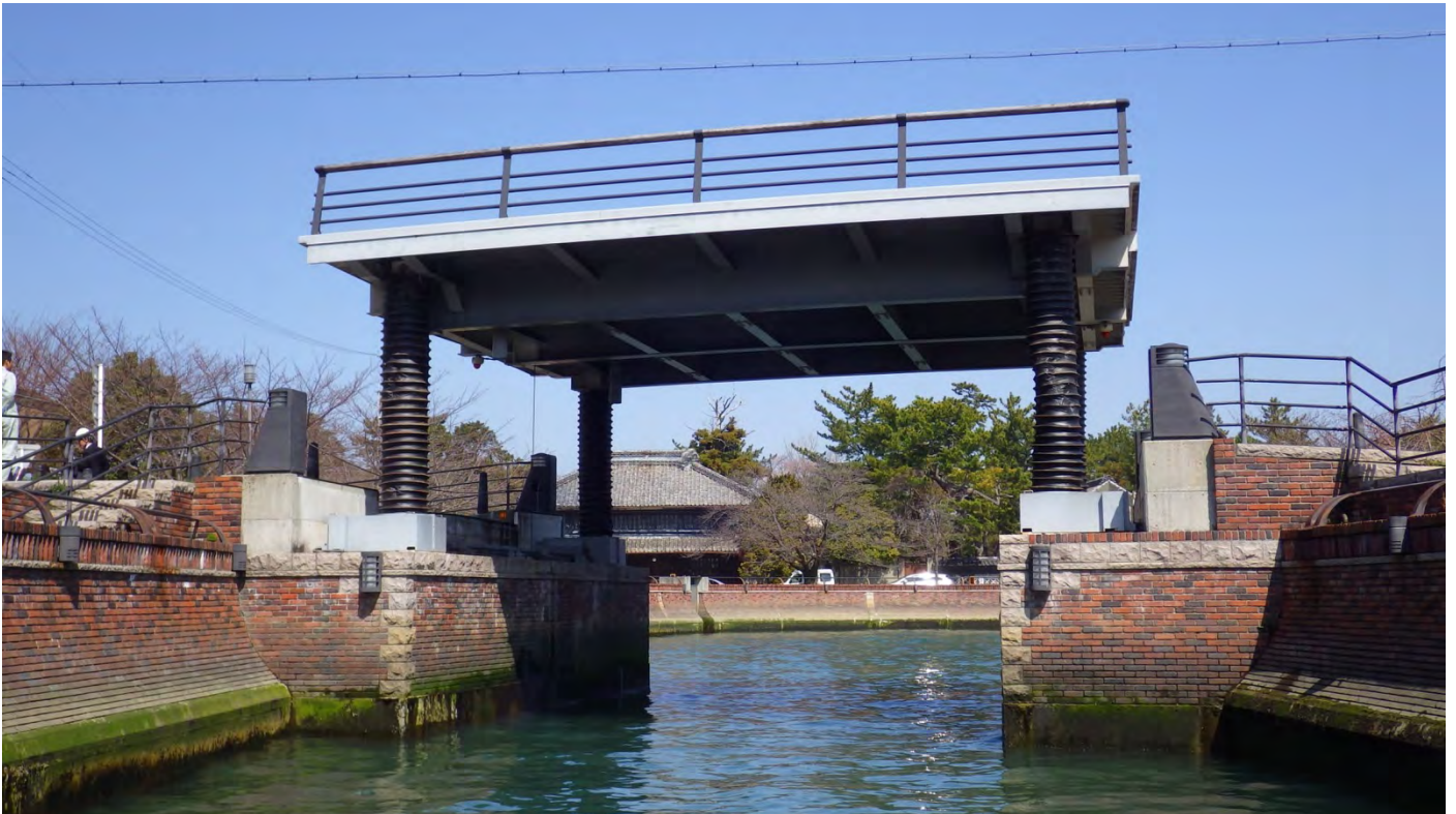
昇開した玉重橋から西諸戸家を透かし見る
