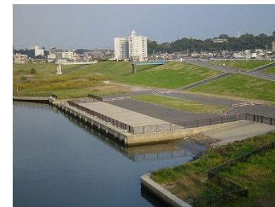
江戸川左岸に設置された緊急船着場 (松戸市小山地先)
