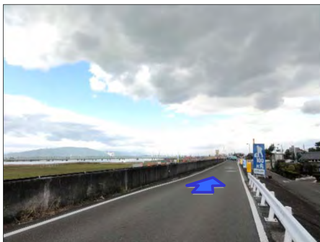
天端道路の狭小区間の一方通行規制化 (木曾川左岸 7.6k付近)
