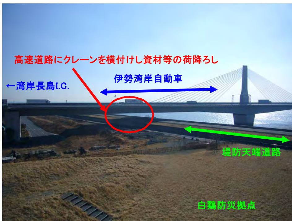
高速道路と堤防天端道路の立体交差部 (長良川左岸0.0k付近)
