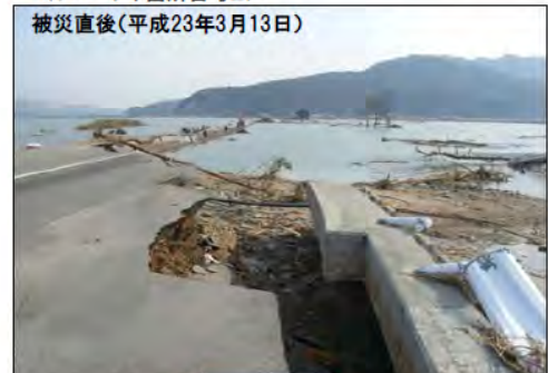
●北上川右岸4.0km付近(宮城県石巻市針岡) <7ページ、箇所番号2>
