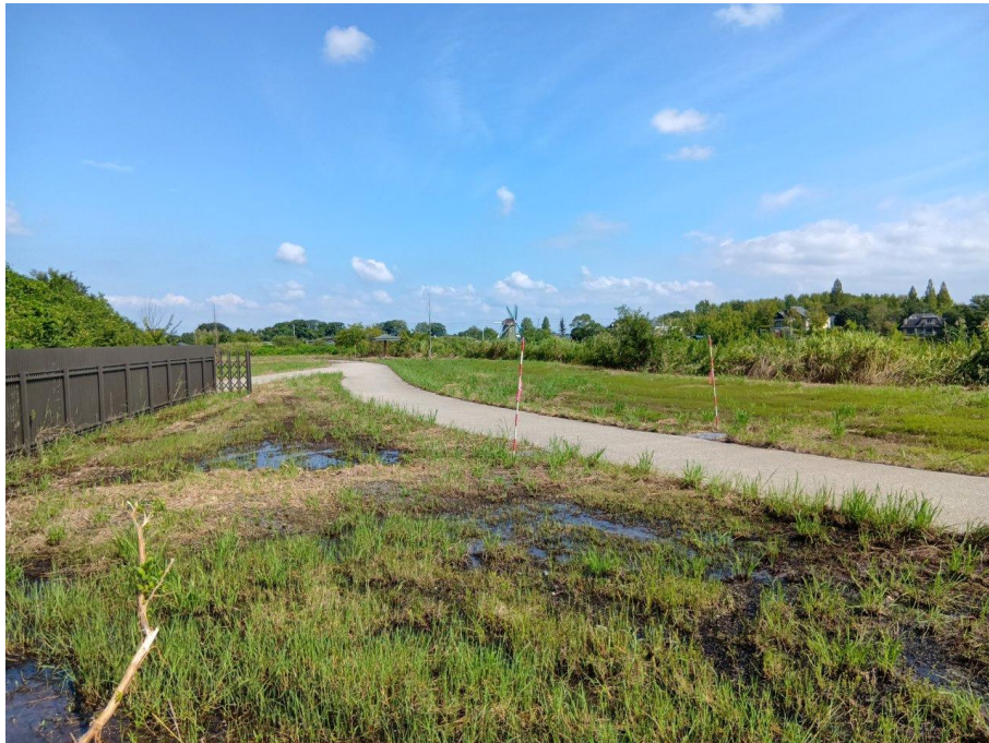
ロープ柵：着手前
