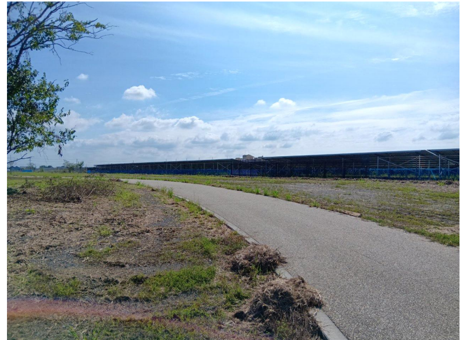
進入防止柵：着手前
