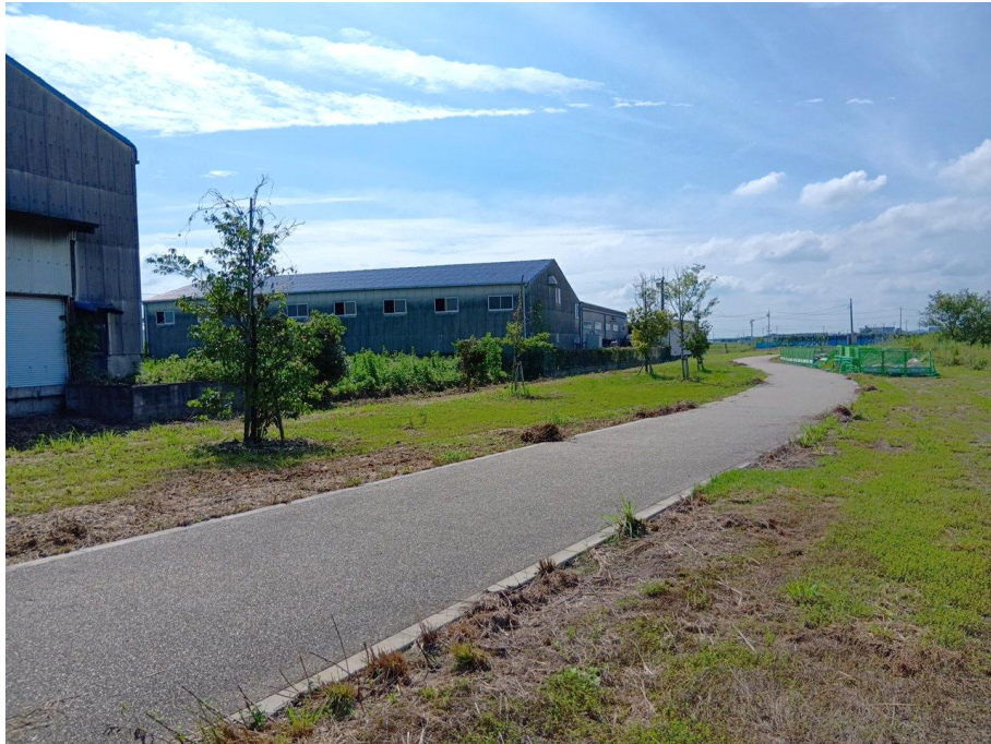
目隠しフェンス・ロープ柵：着手前
