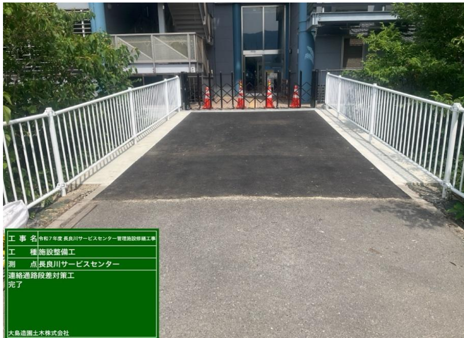
連絡通路段差対策工(全景)
