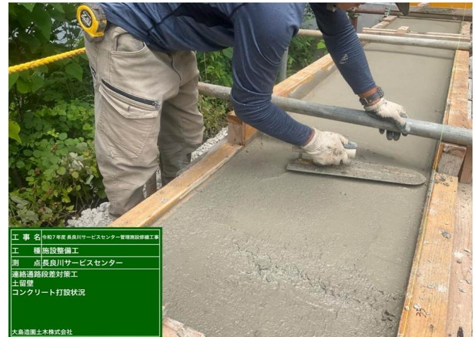
連絡通路段差対策工(施工状況)
