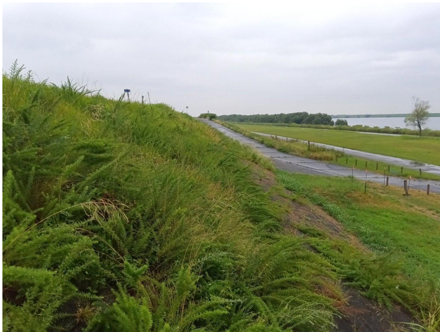
長良右岸14.0k川表着手前
