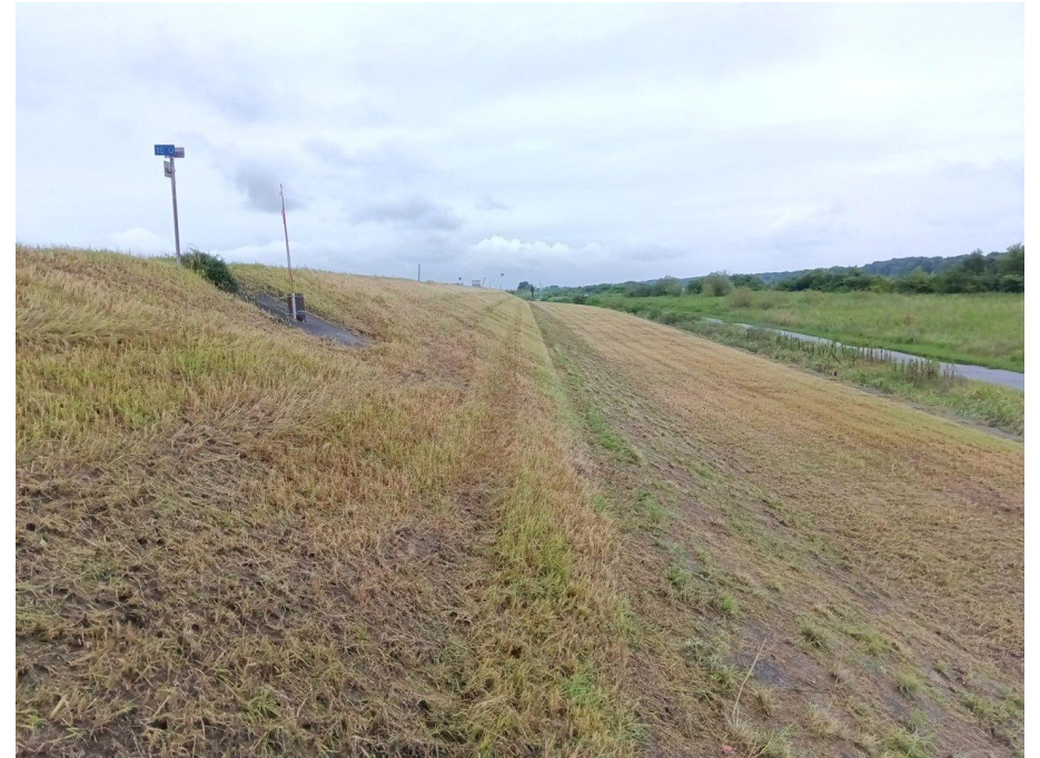
長良右岸18.0k川表完了
