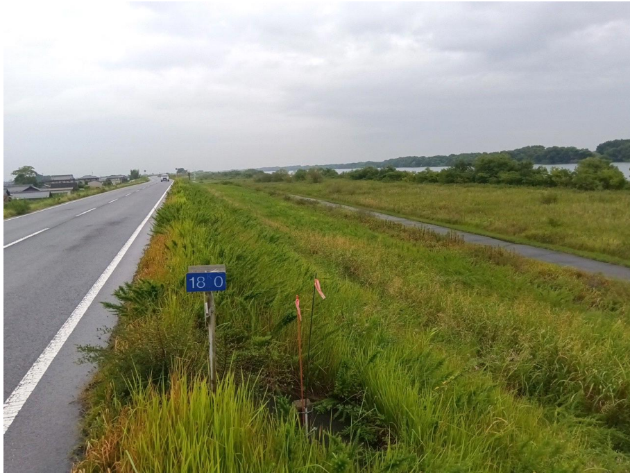
長良右岸18.0k川表着手前
