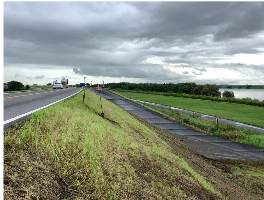
長良右岸14.0k川表完了
