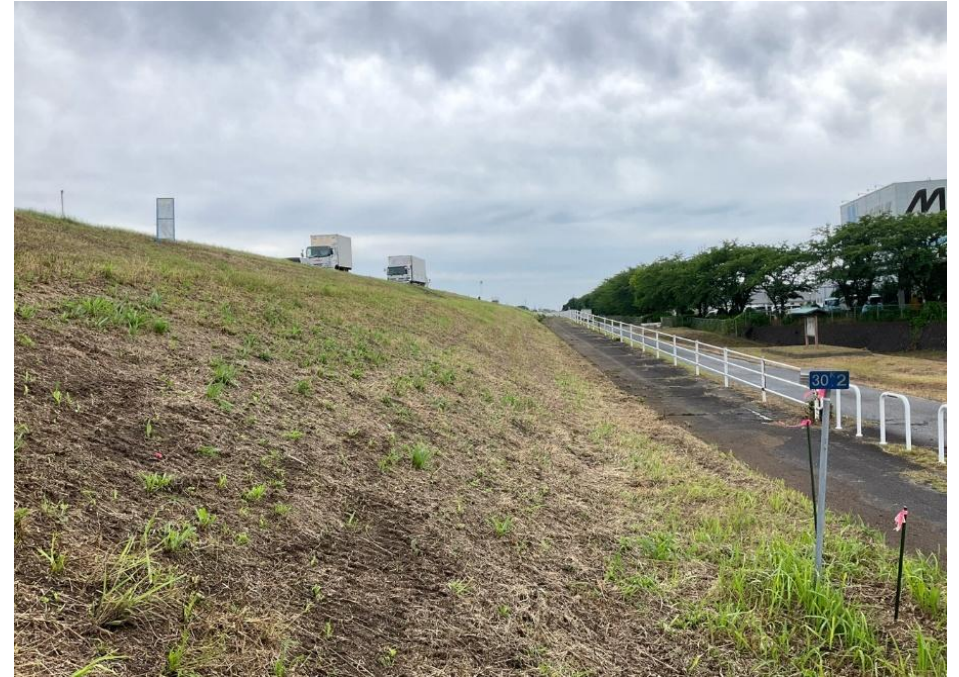
長良川右岸30.2k完了写真
