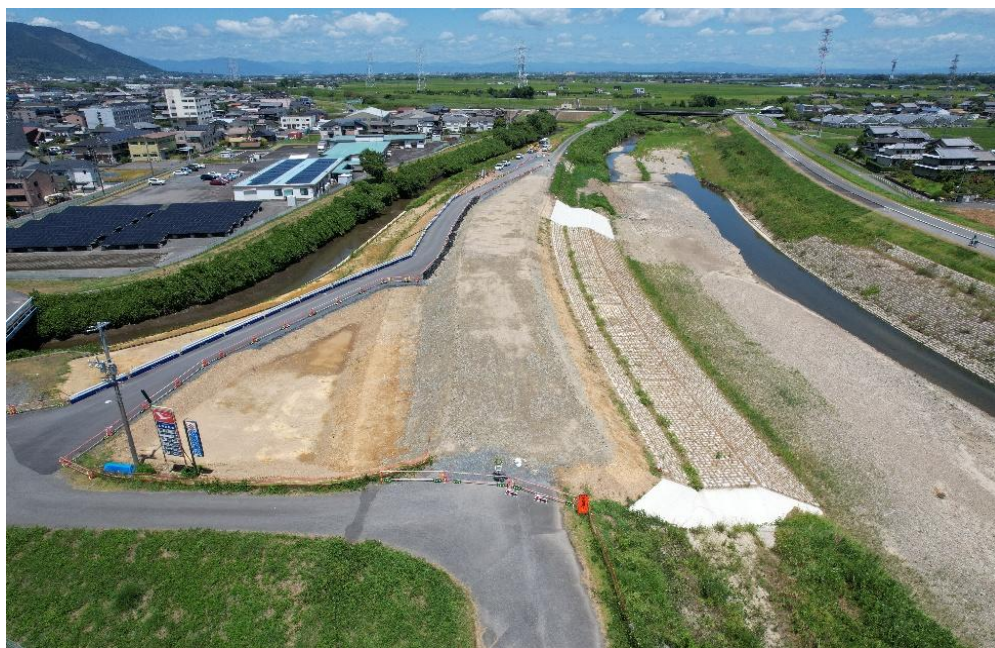
上流より下流を望む
