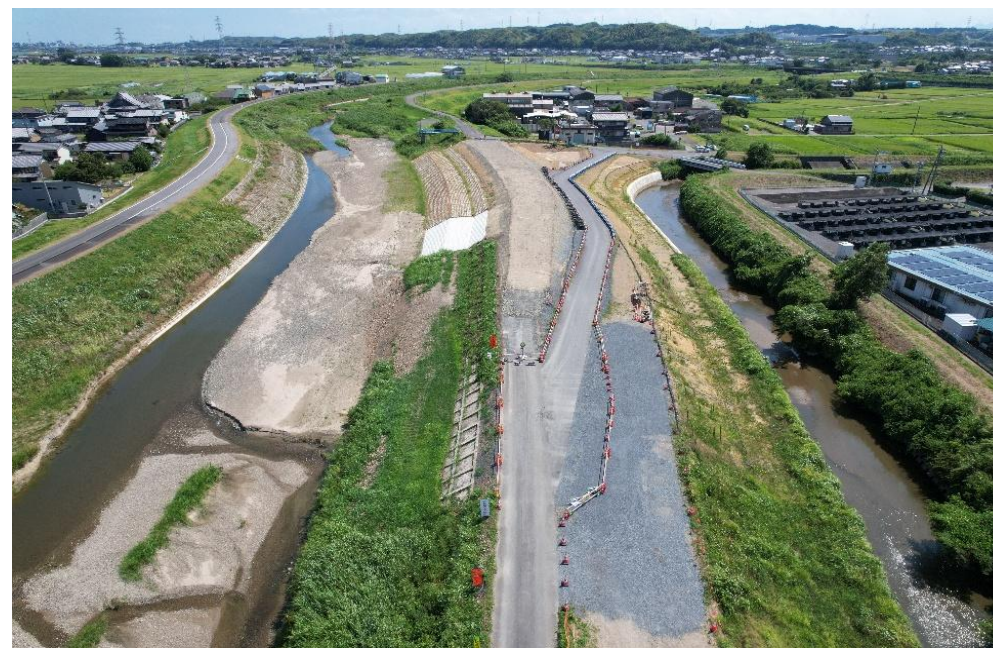
下流より上流を望む
