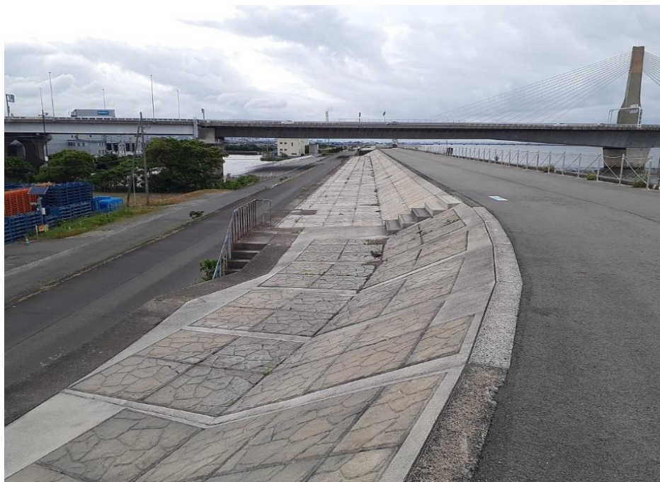
ブロック抜根終了後
