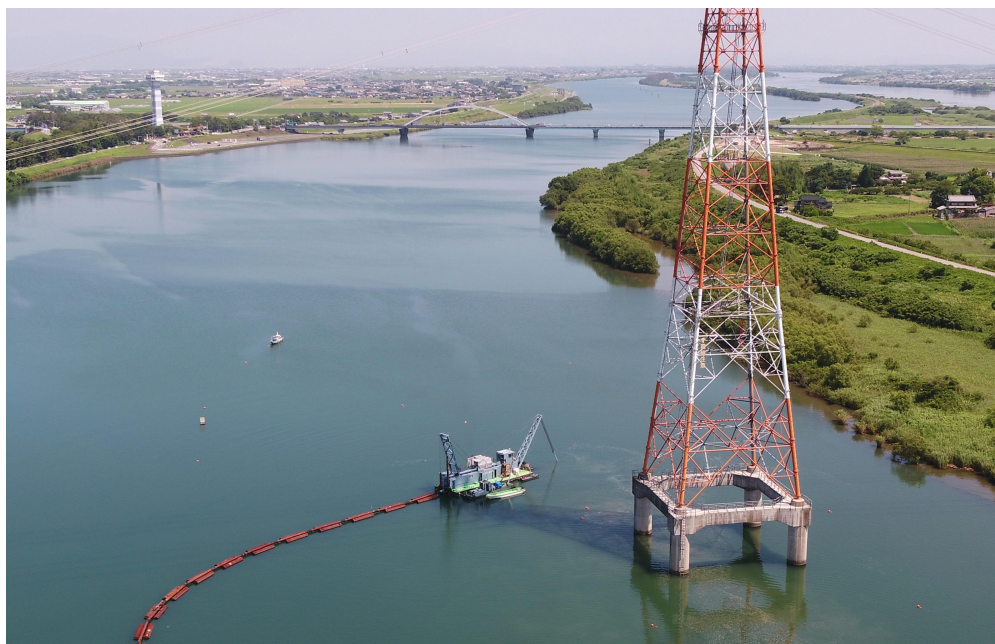
(参考) しゅんせつ作業中
