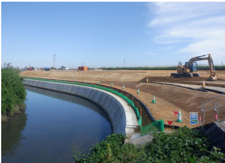
上流側から下流側を望む
