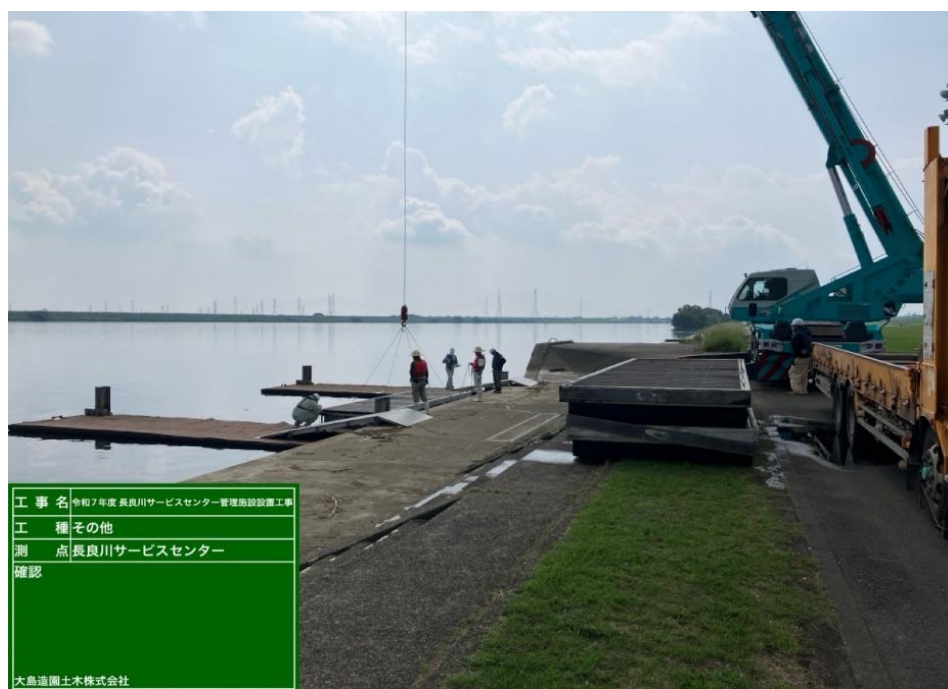
発艇塔基礎確認作業完了
