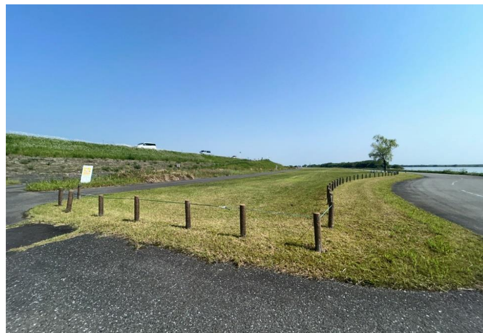
長良川サービスセンター除草完了
