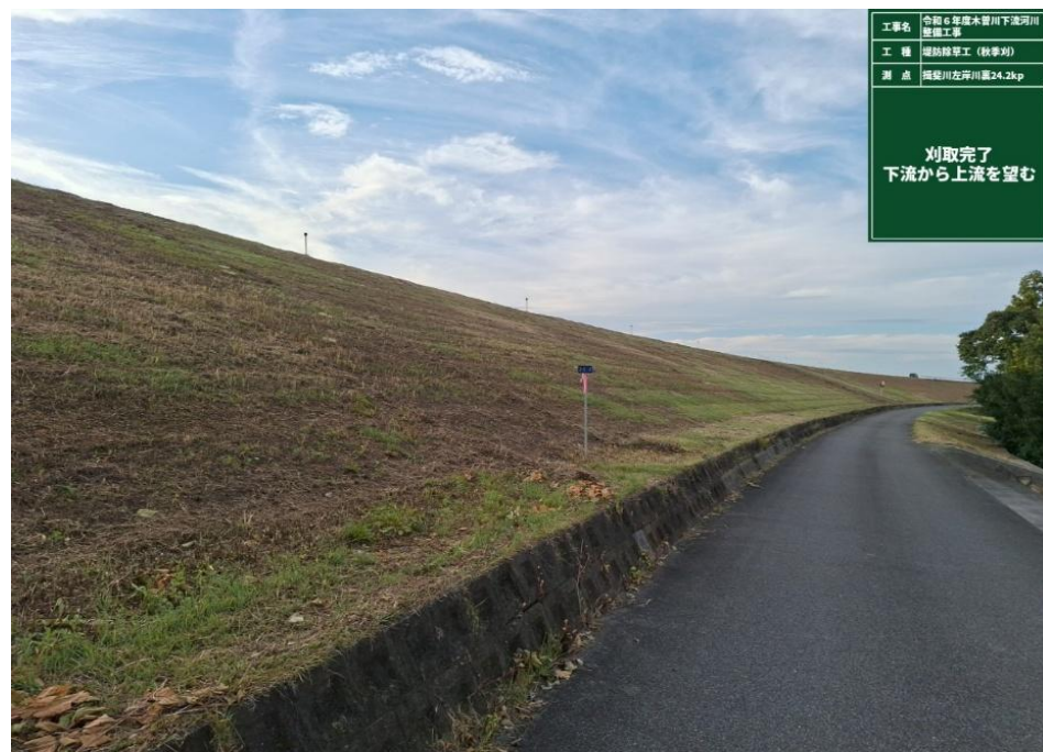
揖斐川左岸(川裏)24.2k下流から上流を望む1
