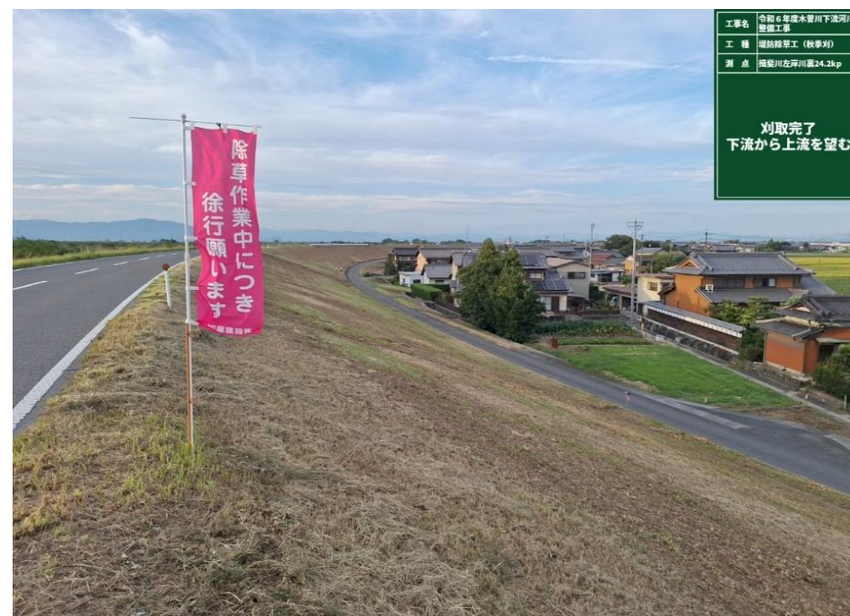
揖斐川左岸(川裏)24.2k下流から上流を望む2
